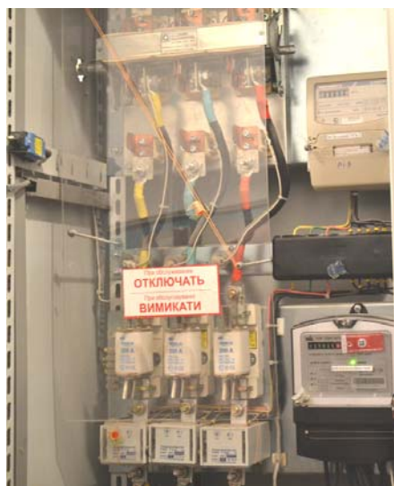
Рис. 3.17. Фотографія електрощитової ЗРГ з приладами обліку
