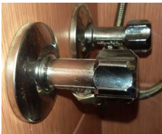
а Рис. 3.18. Підведення водопостачання через штуцер: а – відведення зі стіни, б – відведення з підлоги
