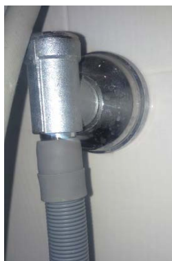
Рис. 3.20. Підключення обладнання до каналізації: а – через шланг та клапан; б – через штуцер
