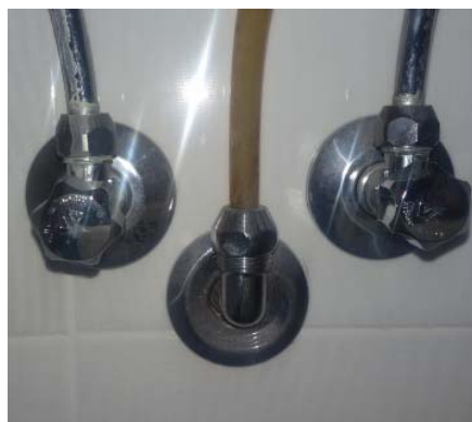
Рис. 3.20. Підключення обладнання до каналізації: а – через шланг та клапан; б – через штуцер
