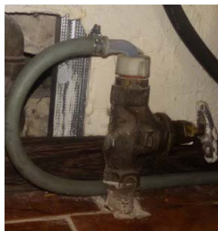
а Рис. 3.18. Підведення водопостачання через штуцер: а – відведення зі стіни, б – відведення з підлоги
